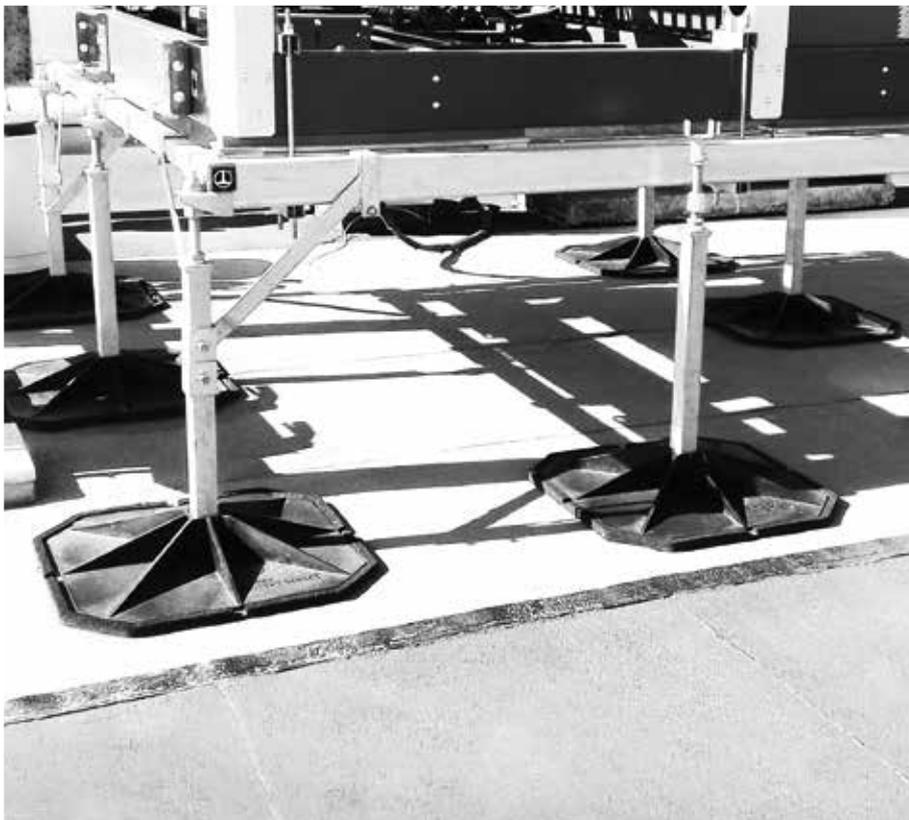
Les locaux de l'entreprise devaient supporter un groupe d'eau glacée de 1600 kg et, en raison de l'âge du toit en asphalte, le client a demandé une solution avec une pression pied inférieure à 10 kN/m<sup>2</sup>.
